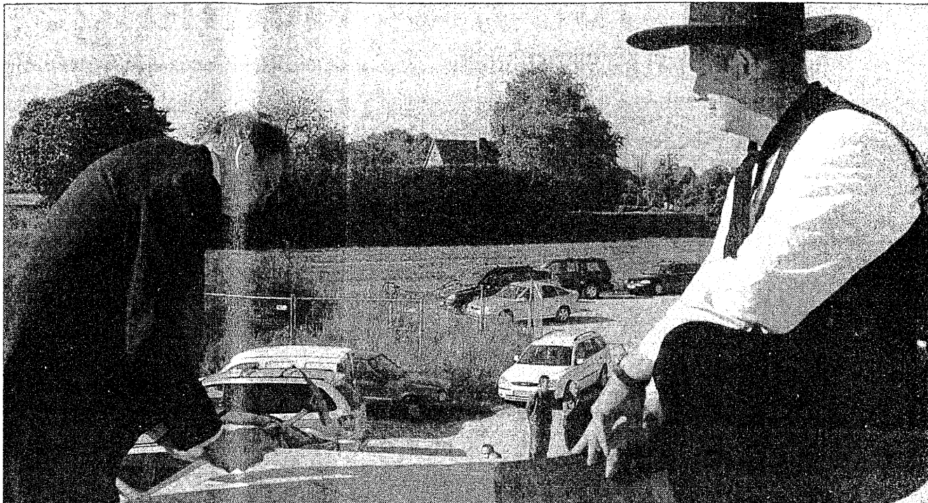
Symbolischer Akt auf dem Dach: Rainer Rabsahl (links) schlug, ebenso wie Architekt Störmer und Dieter Rudolph vom leitenden Ingenieurbüro, einen Nagel ein. Zimmerer Bernd Schüring (rechts) trug den Richtspruch vor. (Foto: Markus Joosten)
