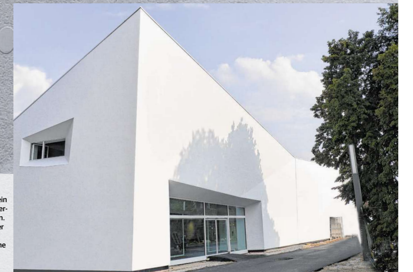
Das neue Museum soll wie ein gefaltetes Papierobjekt aussehen. Für die Rohbauer waren die Schaltungsarbeiten eine große Herausforderung.
